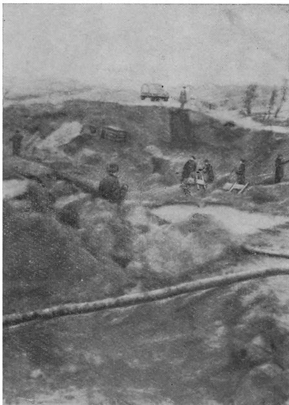
Рис. 31. Воронка на шоссе, образованная взрывом крупного сосредоточенного заряда ВВ. 1943 г.
