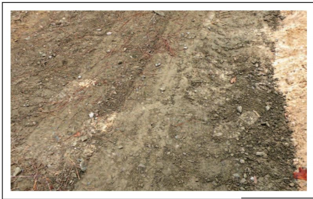
Рис. 1-24. Изменение окраски на обочине грунтовой дороги (справа налево).
